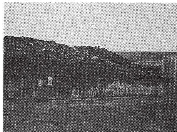
写真-3 舗装発生材のストック状況
