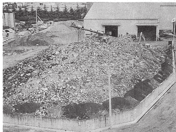
写真-2 発生材ストックヤードの全景
