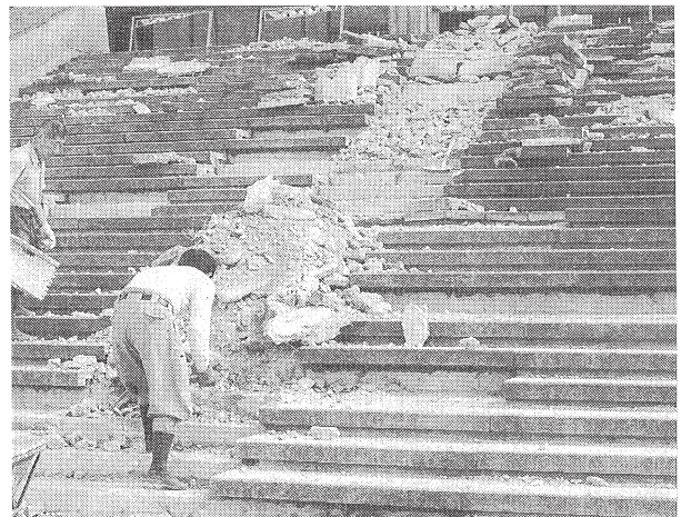
写真5 劣化コンクリート製品の取替え工事
