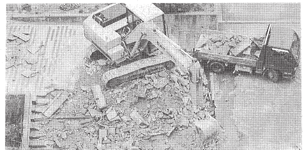
写真6 劣化コンクリート製品の全面撤去工事
