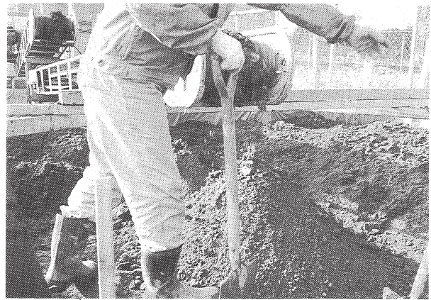
写真2 A区画の混合即時における処理土の状態
